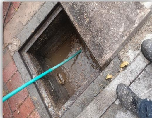
*Ilustración 26. Limpieza cajas de inspección por parte del todero.*
