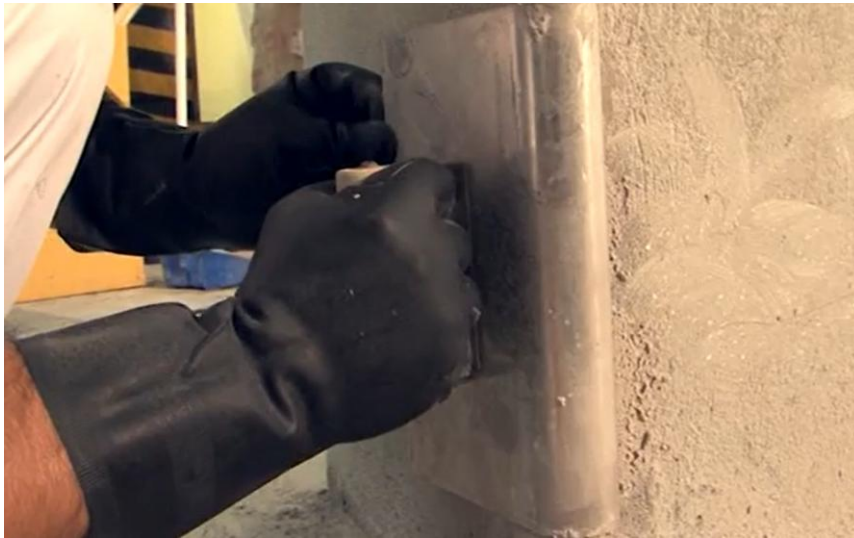
Aplicación de Sikadur®-300
