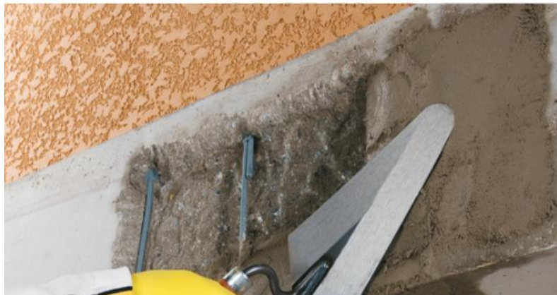
Reparación de elemento en concreto, con mortero de reparación tipo grouting
