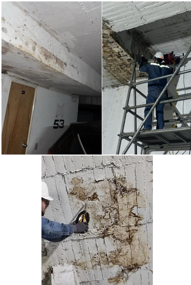
Imagen de elementos a intervenir.
