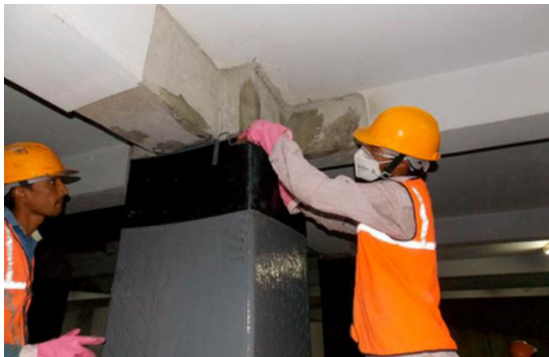
Instalación de SikaWrap®-600
