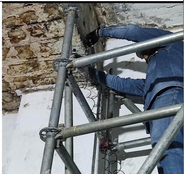
PRUEBA DE ULTRASONIDO AREA CON PERDIDA DE SECCION
