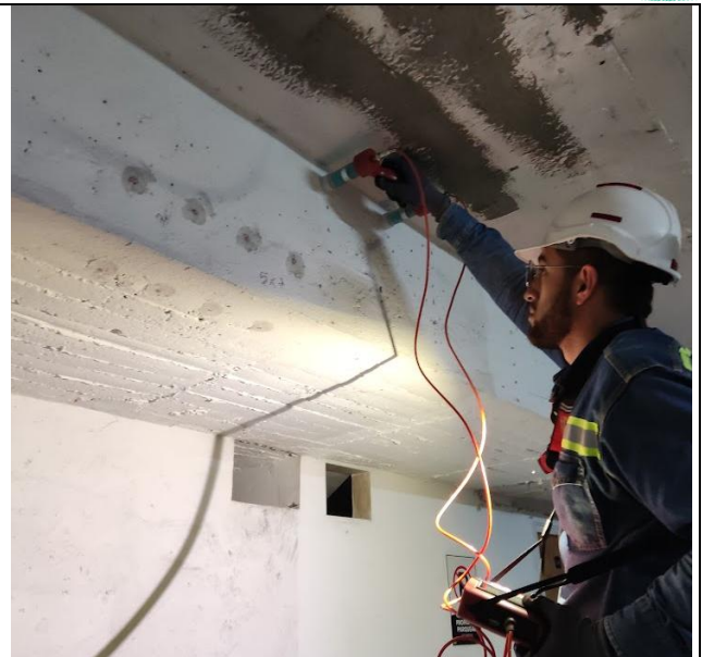
PRUEBA DE POTENCIAL DE CORROSION V-S.N
