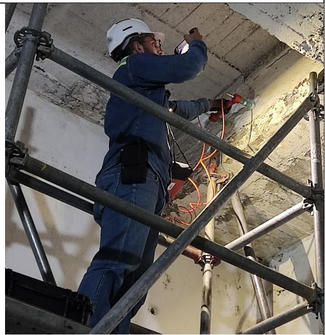
PRUEBA DE POTENCIAL DE CORROSION AREA DE LOSA CON HUMEDAD LOCALIZADA
