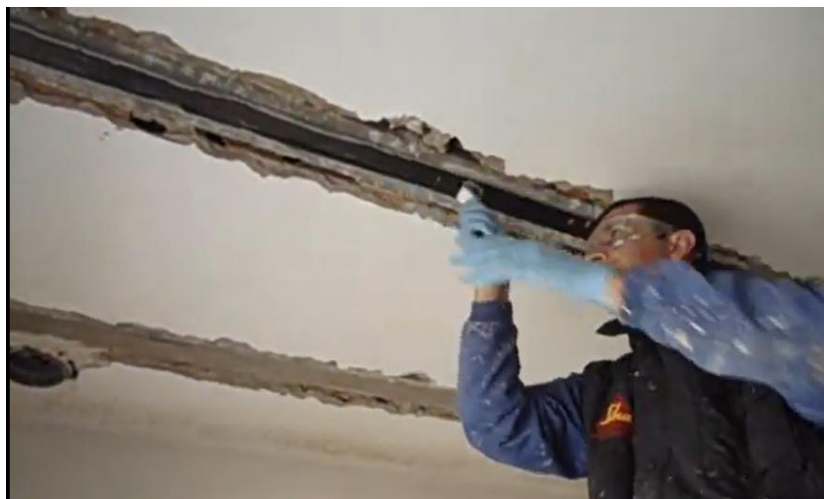
instalación de laminas de SIKA CARBODURE
