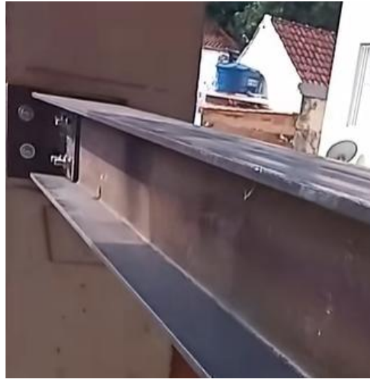
Imagen de soporte izaje de viga
