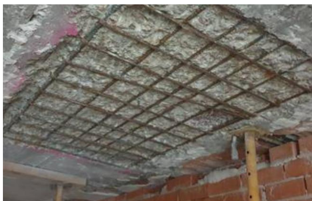
Imagen de concreto escarificado hasta encontrar un área sana
